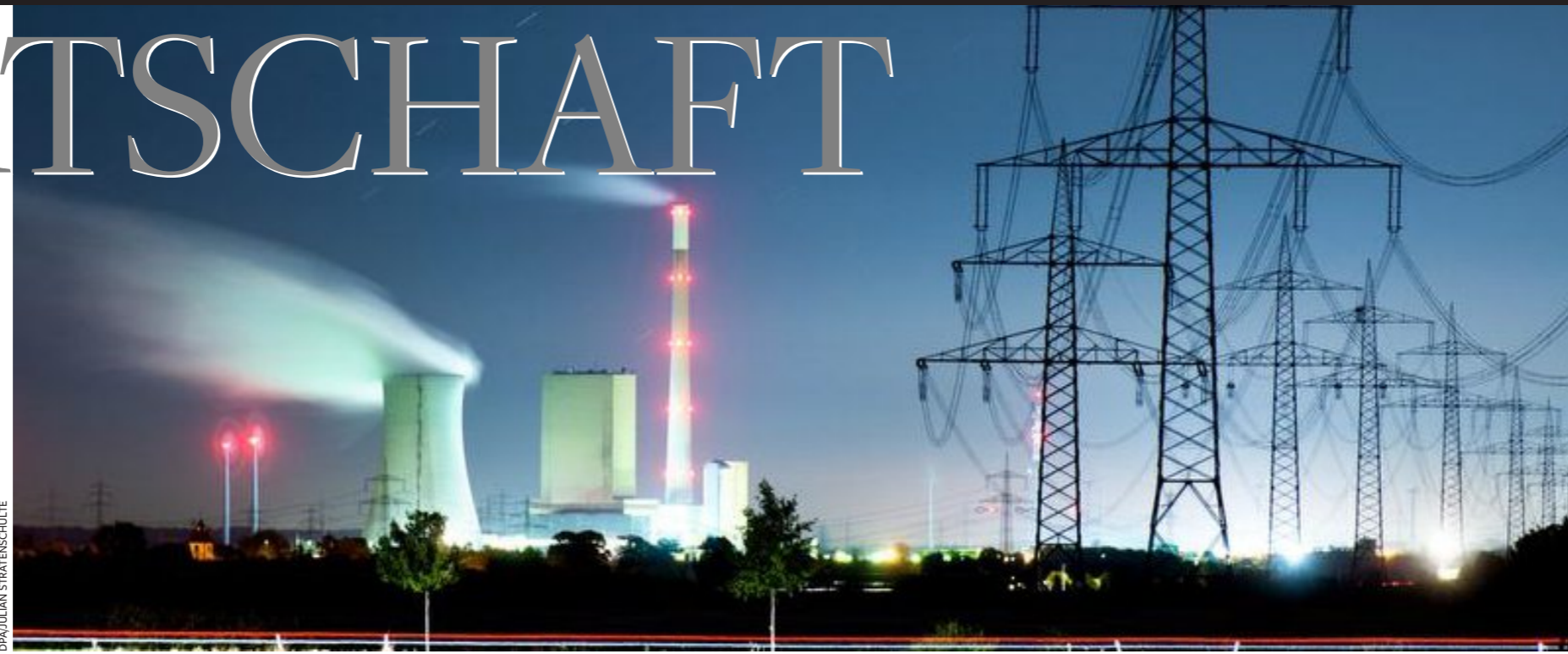
Kohlekraftwerk Mehrum in Niedersachsen. Im deutschen Energiemix macht die klimaschädliche Kohlekraft knapp 45 Prozent aus
